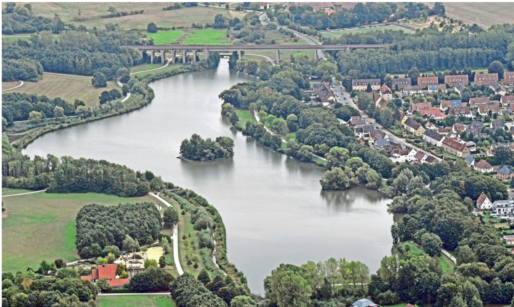
In der Johannisbachaue auf der Ostseite des Viadukts (hinten im Bild) würde der Untersee entstehen. Im Vordergrund auf dem Bild ist der Obersee zu sehen.
